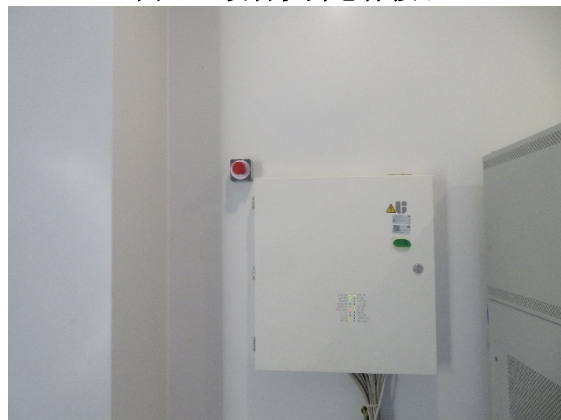
图 3-6 机房内墙面急停按钮（二）
