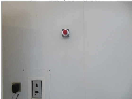
图 3-5 机房内墙面急停按钮（一）
