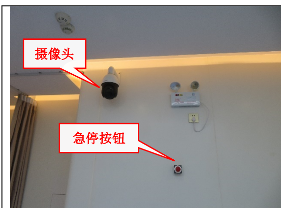
图 3-7 机房内墙面急停按钮（三）
